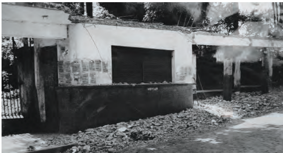
Demolição do abrigo de ônibus situado na Rua Barão de Tefé, Petrópolis (RJ). Foto de Pierre Garnotel, 1965. ACI/ RJ. Série Obras.
