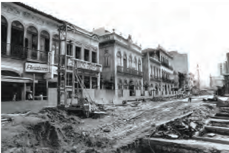
Rua do Catete em obras. Foto de Eurico Antônio Calvente, 1976. Arquivo Central do IPHAN/Seção Rio de Janeiro. Série Inventário.
