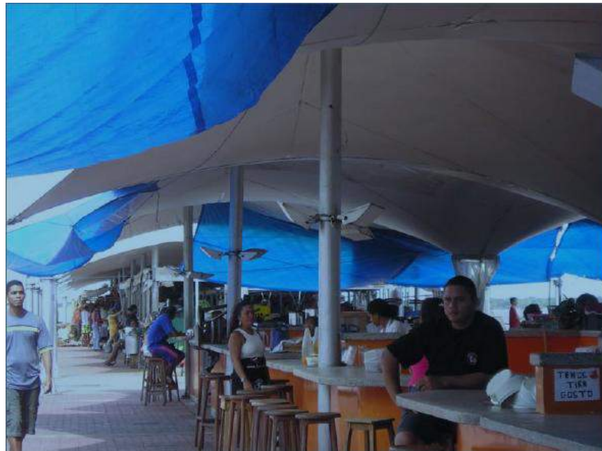
Interferências feitas pelos feirantes datam de mais de 10 anos. Fonte: Fontenele, Helane B., Use e adequação de Tensoestruturas à Região Amazônica, Data: maio, 2005.
