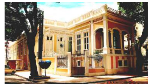
Revitalização - Casarão Chão e Teto
