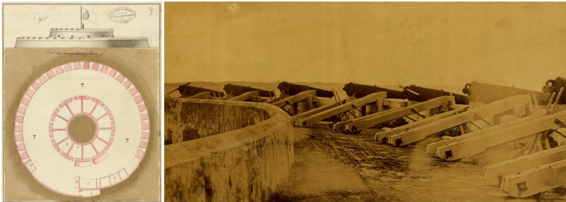
Forte de São Marcelo, Salvador, BA. Processo inscrito, em 24 de maio de 1838, nos livros do Tombo Histórico e de Belas Artes. A planta, de 1799, mostra o forte com seu desenho original, com os muros tendo canhoneiras. A foto, de 1866, mostra sua configuração estabelecida na década de 1820, com as peças disparando a barbete, por sobre o muro (CASTRO, 2013).
