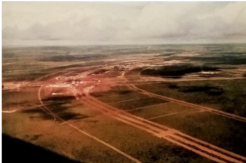
Fig. 5: Ao fundo, vê-se parte da Asa Sul em construção, mais adiante as obras da Rodoviária do Plano Piloto, e, em primeiro plano, o Traçado dos eixos principais da Asa Norte. CRÉDITO/FONTE: Mário Fontenele/Arquivo Brasília.
