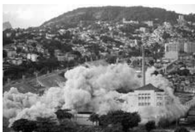
Implosão da antiga fábrica da cervejaria Brahma. Foto: Beth Santos/Divulgação/PCRJ
