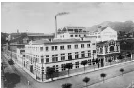
Fábrica da Brahma. Foto: retirada do site da Brahma. Disponível em: < http://www.brahma.com.br/sabor/2010/0-comeco-de-tudo/#post-content >
