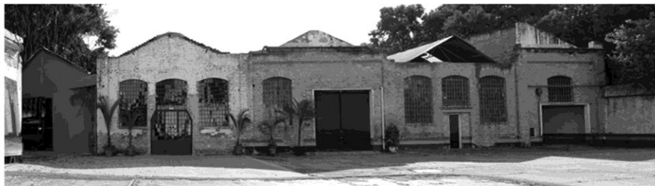
Fachada NE. Existente
