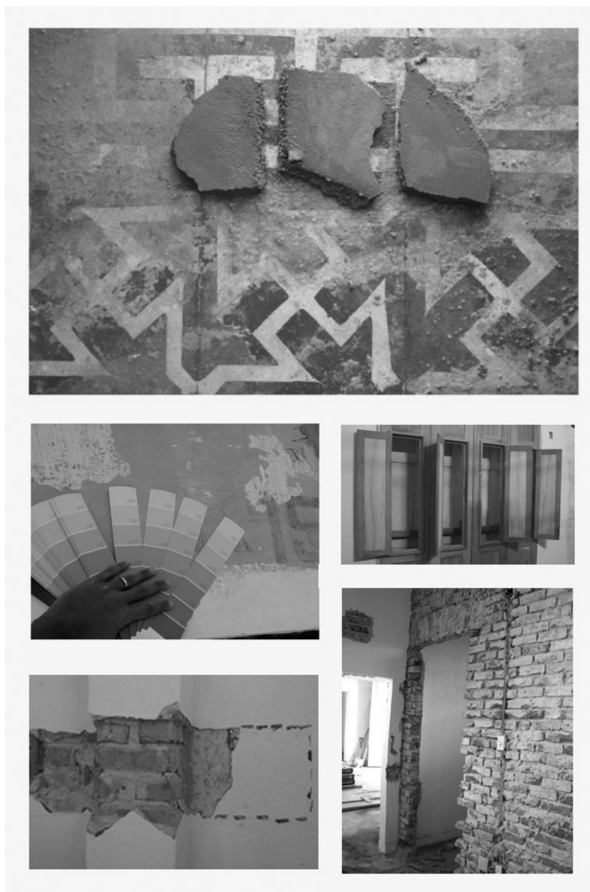
Figura 03: De cima para baixo, esquerda para direita: 1. Estudos de cor para cimento queimado na cor vermelho, tendo como referência o ladrilho hidráulico existente./ 2. Comparativo de cores para identificação em catálogo PVA Sherwin-Williams da cor equivalente à tonalidade inicial./ 3. Postigos adaptados nas novas esquadrias./ 4. Janela de inspeção de suposto pilar, comprovando alvenaria portante mesmo nos ressaltos./ 5. Parede interna original, apresentando, sobre o vão, arco de descarga em tijolos.
