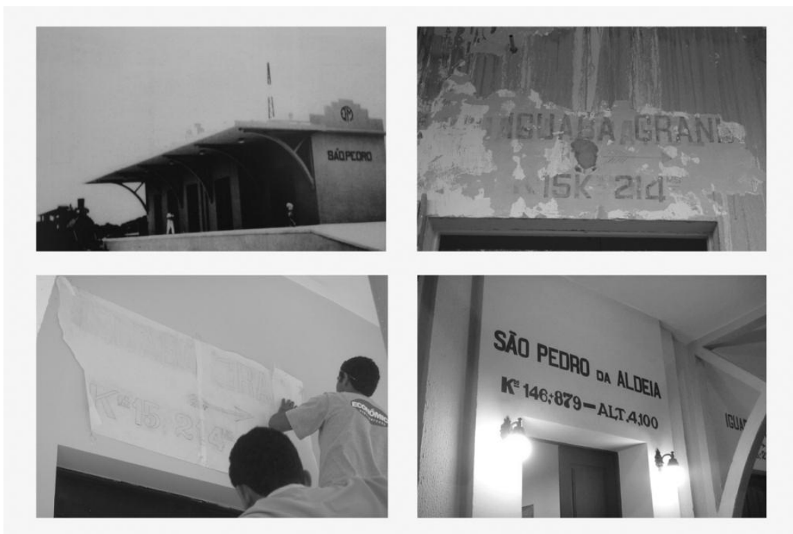
Figura 02: No sentido Horário – 1. Foto contemporâneas á inauguração (final da década de 1930), onde se pode ver os letreiros originais, tipos de luminária e diversos outros aspectos da arquitetura./ 2. Aspecto dos letreiros descobertos sob a pintura acima dos vãos na fachada principal./ 3. Processo de mapeamento para restauração dos letreiros. 4. Aspecto dos letreiros já restaurados, após finalização da obra.
