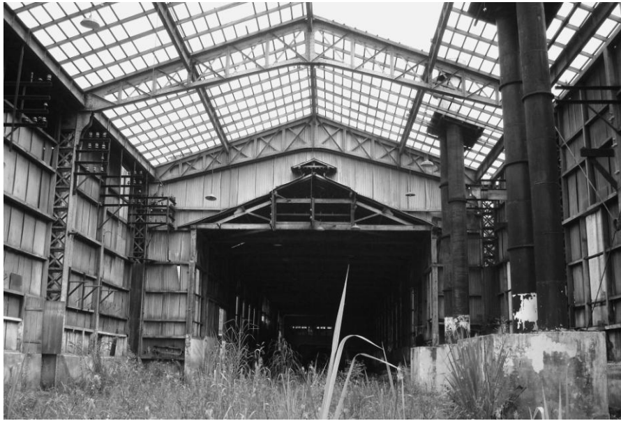
4 - Galpão dos Compressores em 2007. Fonte – Lizandro Melo Franco – acervo pessoal
