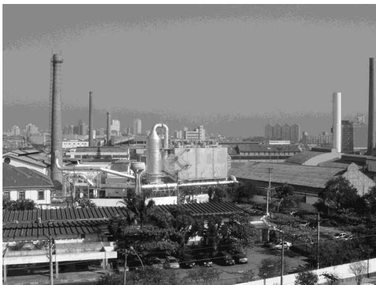
Figura 05: Edifício São Paulo no lado direito, em que se pode verificar a fachada com trama metálica e preenchimento em alvenaria de tijolos aparentes. A chaminé N° 5 na extrema esquerda e chaminé N° 20 na extrema direita. Foto: Autor, 2008.
