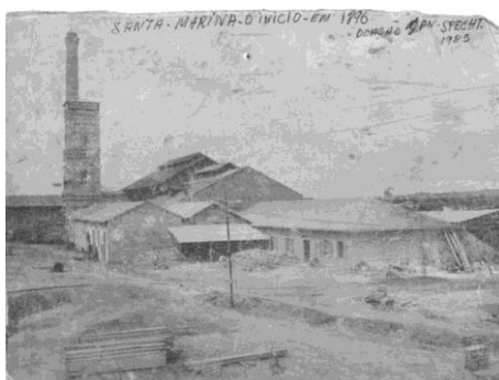
Figura 01: Fábrica de Vidros Prado e Jordão, 1896. Do lado esquerdo verifica-se a denominada “cabine elétrica” remanescente até a atualidade. Fonte: Acervo da Empresa.
