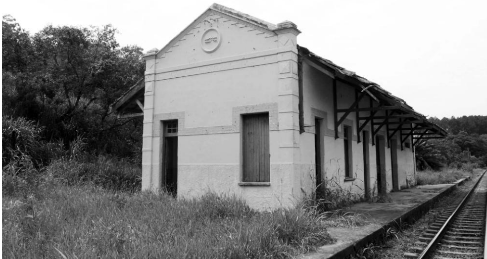
Figura 02. Estação Varnhagem, 2012. Fonte do Autor.
