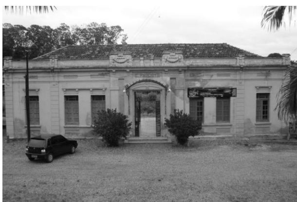
Estação de Torrinha – Fachada. Fonte: Arquivo Pessoal
