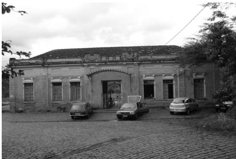
Estação de Brotas - Fachada. Fonte: Arquivo Pessoal
