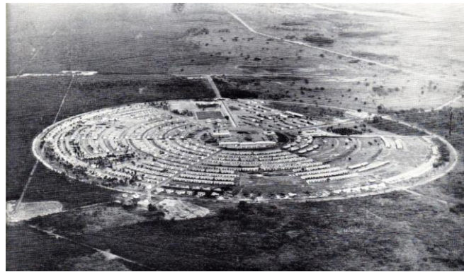
Figura 2: Vista aérea da Vila Piloto de Jupiá. Fonte: PLANEJAMENTO..., 1962, p.03.
