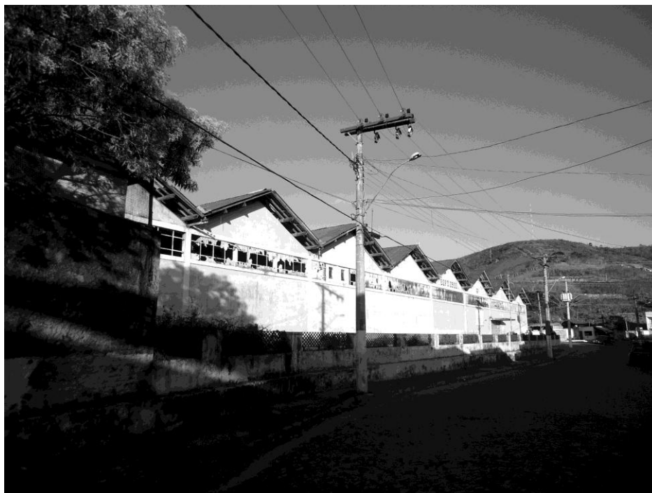
Figura 1. Galpões que fazem parte do antigo complexo da Rede Ferroviária Federal, complexo este conhecido como Quarto Depósito Foto: OLENDER, Mônica C. H. Leite. Data: 06/05/2012
