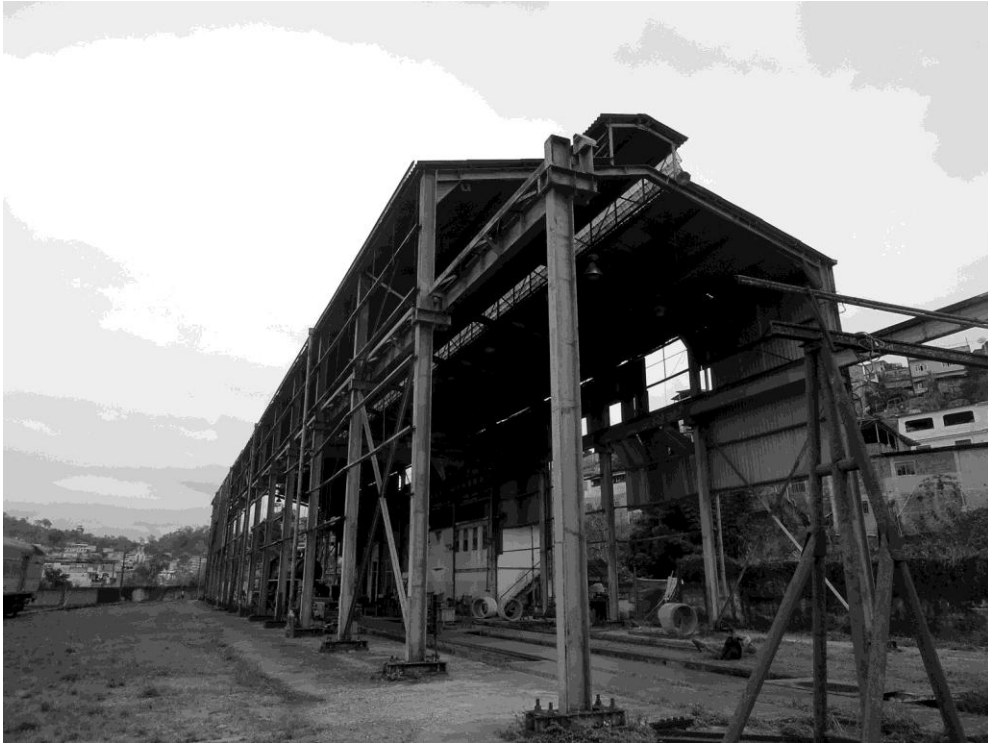
Figura 4. Vista do antigo Galpão de Revisão da RFFSA. Foto: OLENDER, Mônica C. H. Leite. Data: 25/07/2011
