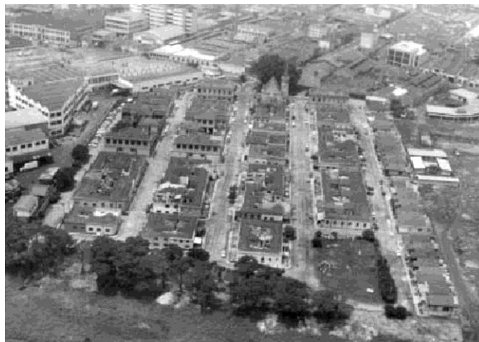
Vista aérea da Vila Maria Zélia, em direção ao sul, implantação do traçado urbano com a igreja ao fundo, em 1978.
