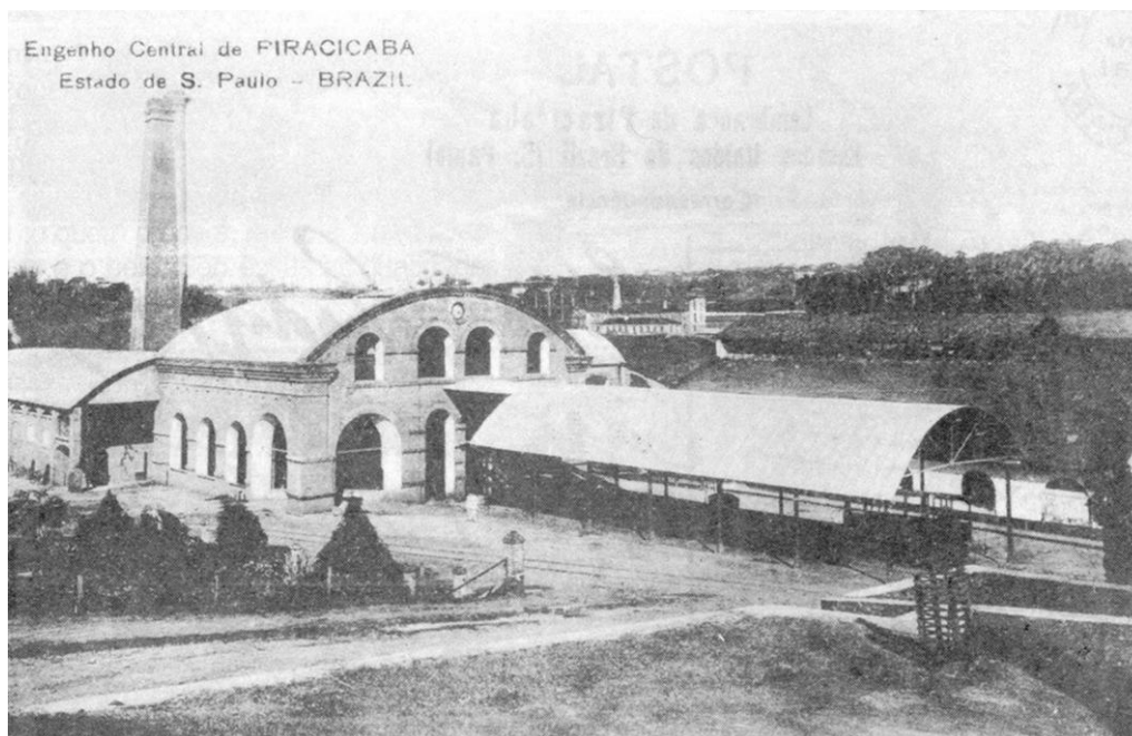
Figura 05: Edifício 5 - antiga Moenda, com a fachada original. (Pinto & Zenha, 1990).
