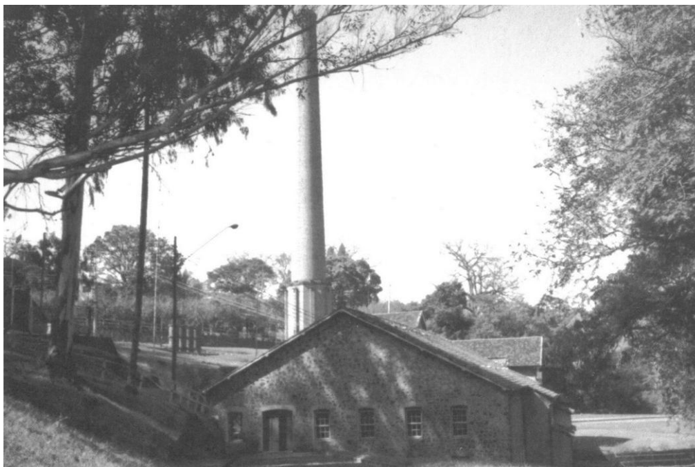
Figura 02 – vista externa da casa de máquinas da Usina do Corumbataí – s/d (fonte: FPHESP, 2000).
