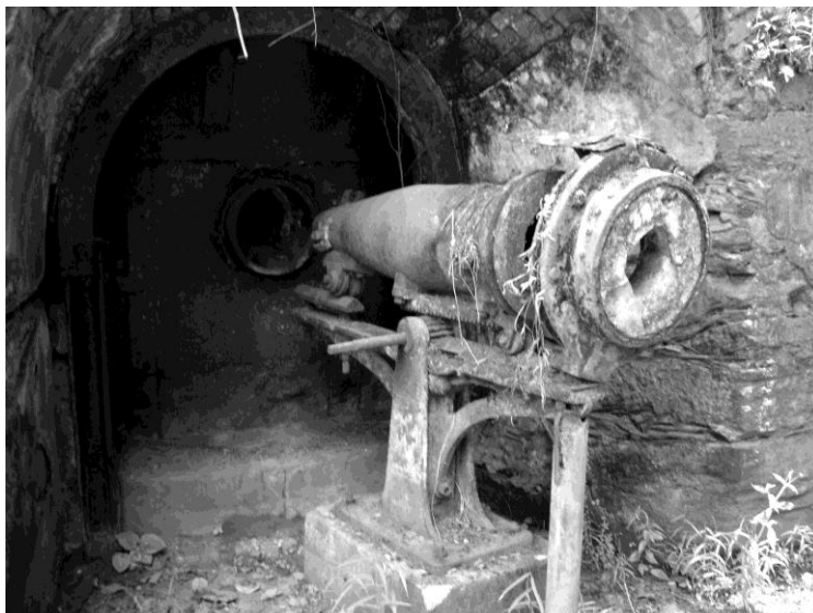
Vista da ventaneira lateral, Usina Wigg. Município: Ouro Preto, MG. (Foto A. Baeta em 2010)
