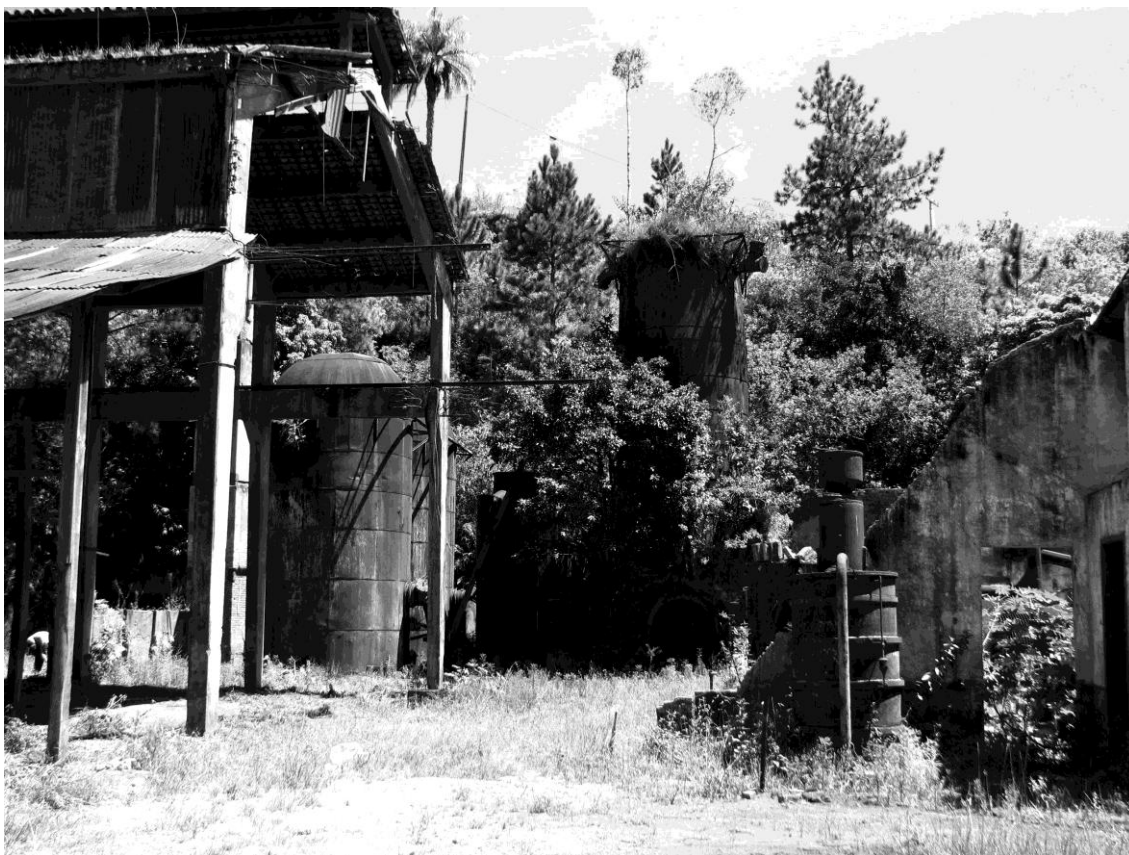
Vista geral do sítio histórico arqueológico Usina Wigg. Município: Ouro Preto, MG. (Foto H. Piló em 2010)
