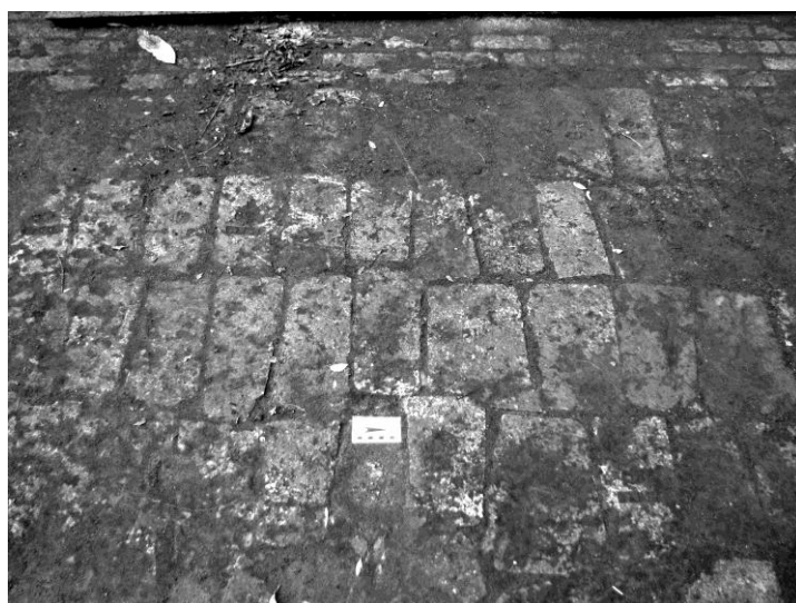
Piso de tijolos e identificação de sua disposição. Usina Wigg. Município: Ouro Preto, MG. (Foto H. Piló em 2010)
