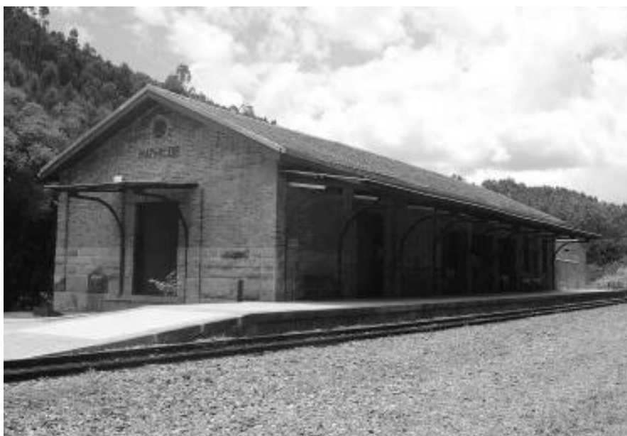
Estação de Mathilde e o detalhe para a estrutura da marquise. Fonte: Arquivo pessoal.
