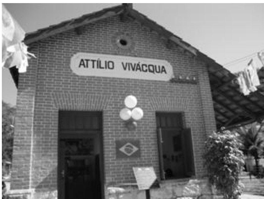
Estação de Atílio Vivácqua e o detalhe da verga em arco reto e do óculo. Fonte: Arquivo pessoal.
