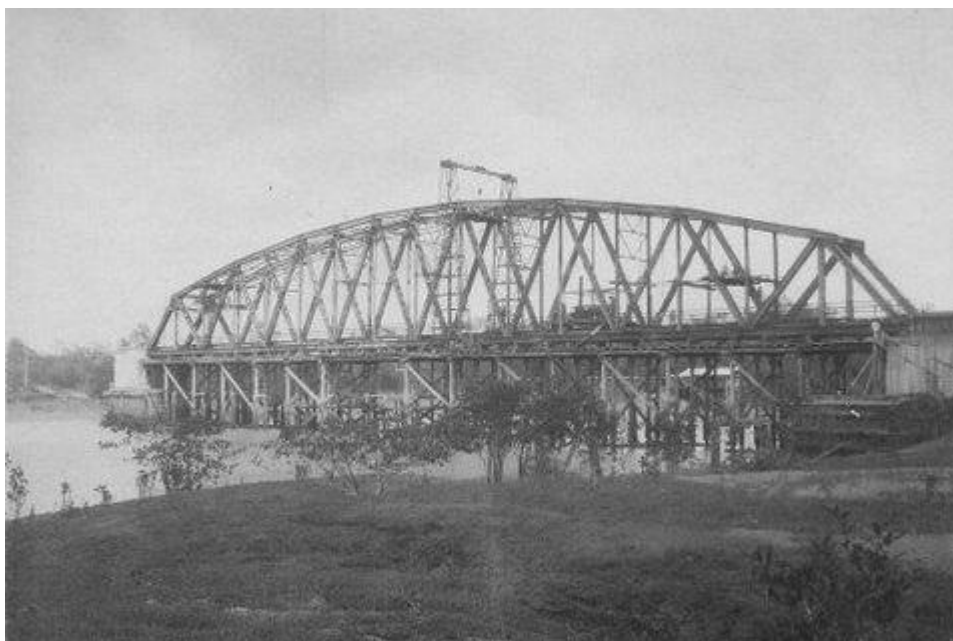
IMAGEM 02 – Ponte metálica sobre o Estreito dos Mosquitos, São Luís, década de 1920 (Cortesia de Rosa Paxeco Machado).
