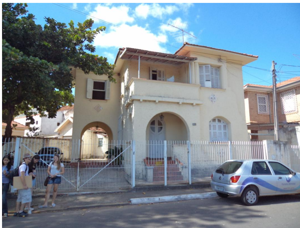
Foto 2. Vila dos Engenheiros da EFNOB Bauru. Fonte: Salcedo, abril de 2012.
