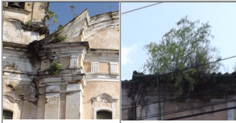
Figura 4: Presença de vegetação na fachada da Igreja de Nossa Senhora das Mercês pela Rua Gaspar Viana e pela Travessa Frutuoso Guimarães
