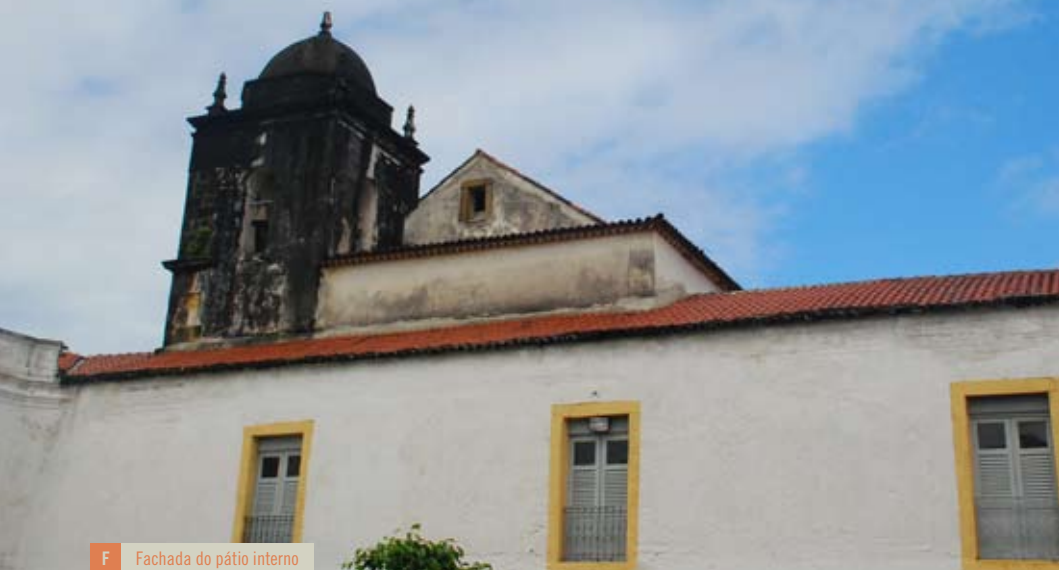
F Fachada do pátio interno
