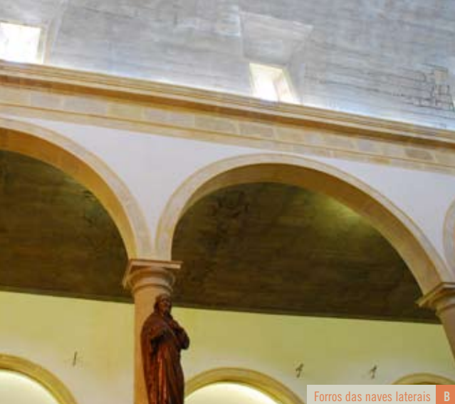
Forros das naves laterais B
