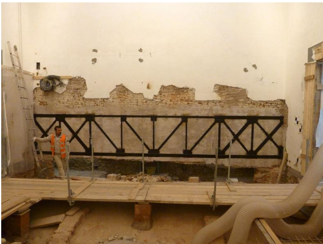
Imagem 04: Reforço estrutural de paredes (portantes) com treliça metálica. (FONTE: < www.nuoviuffuzi.it >. Acesso em 10/11/2014).
