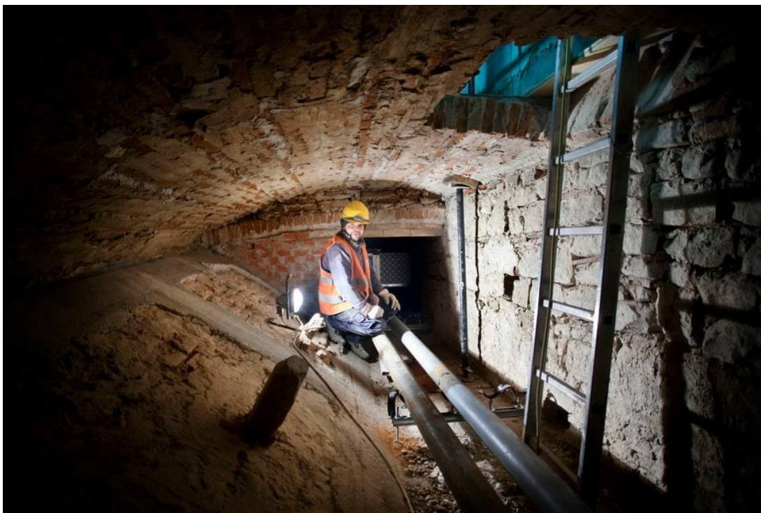
Imagem 02: O espaço entre voltas e contravoltas antes do reforço estrutural, com a passagem de dutos de infraestrutura. (FONTE: < www.nuoviuffuzi.it >. Acesso em 10/11/2014).
