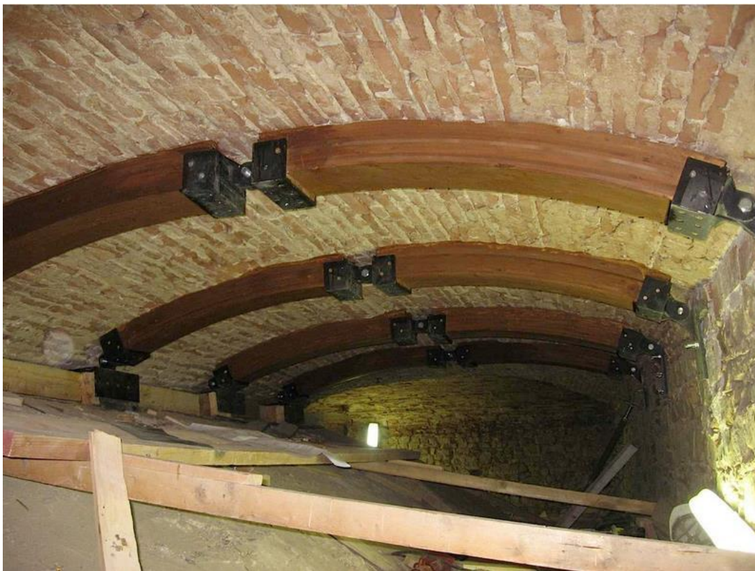
Imagem 03: Arcos em madeira para resistência contra sismos das contravoltas. (FONTE: < www.nuoviuffuzi.it >. Acesso em 10/11/2014).
