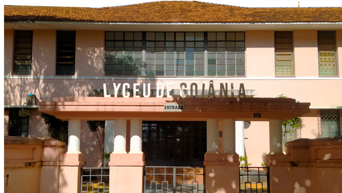
Lyceu de Goiânia: Volume da cobertura se revela, sem uso de platibanda característico dos demais edifícios. Maria Cassani. 2023.
