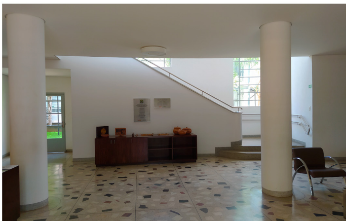
Delegacia Fiscal: Hall de entrada com mezanino na escada. Maria Cassani. 2023. Fonte: IPHAN-GO.
