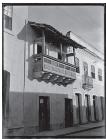
Casa na Rua do Amparo, nº 28. Antes e depois da restauração.
